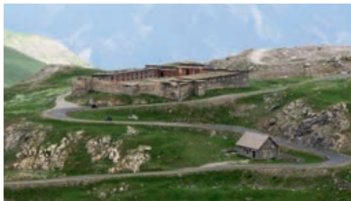
Casernement de Restefond
