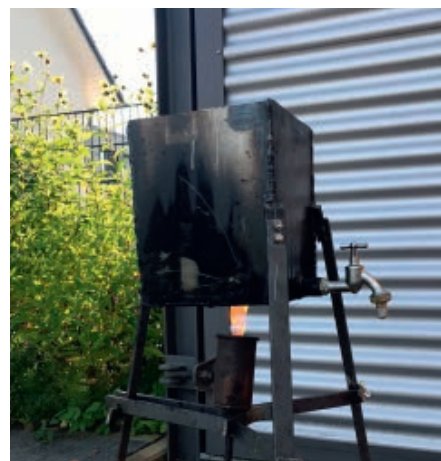
Vorbereitung zur Hohlraumkonservierung
