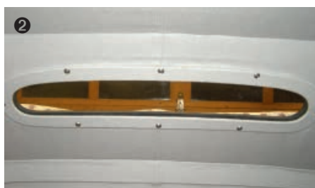
Das fertige Schießschartenfenster
