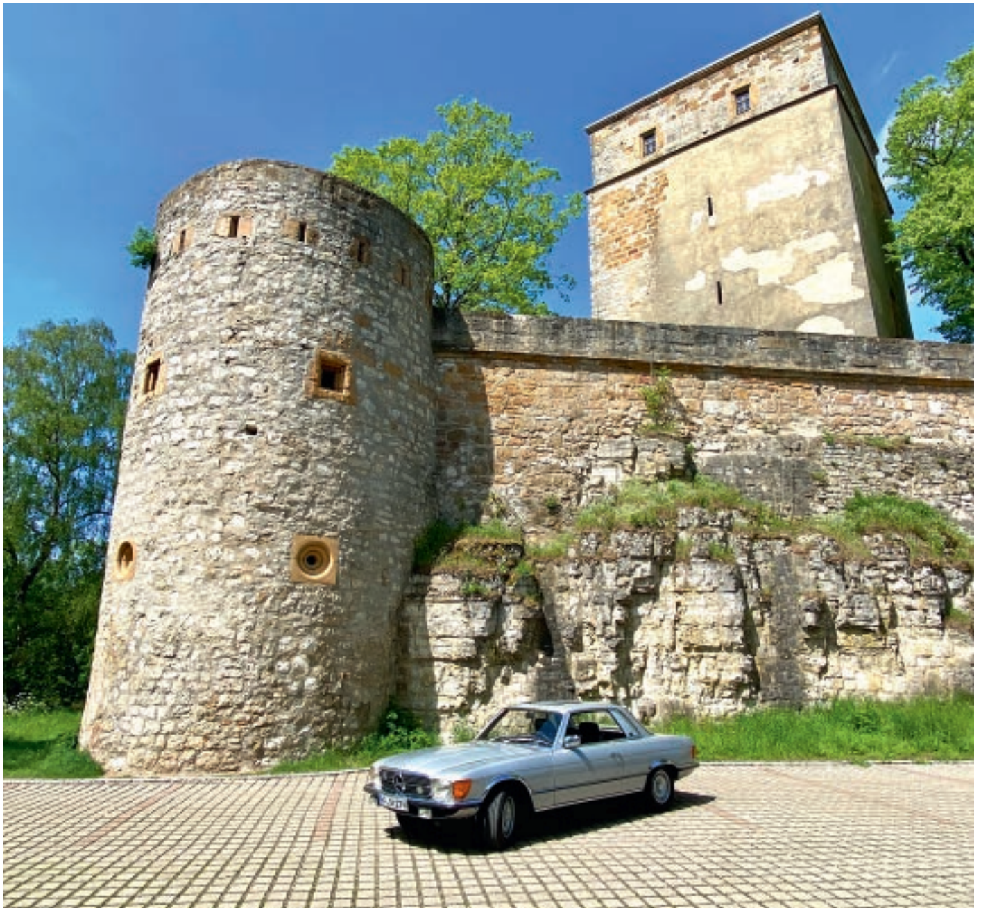
Imposante Festungsanlage Giechburg
