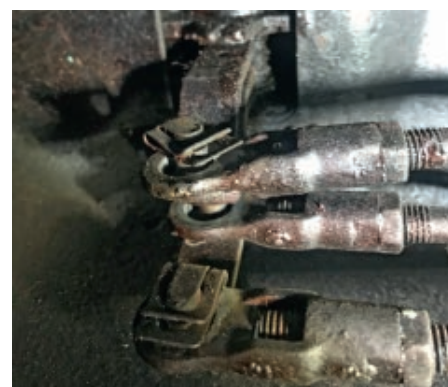
Schaltgestänge, Gummibuchsen nicht mehr existent
